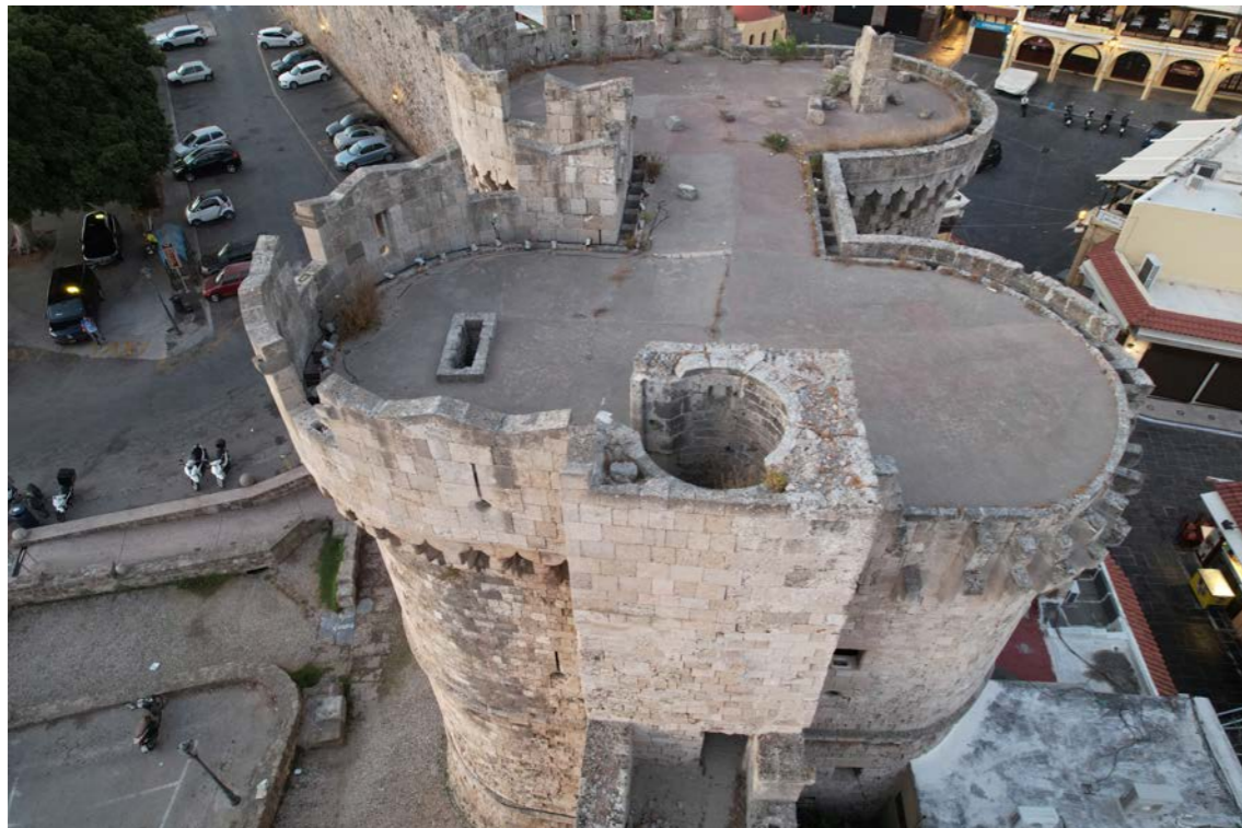
Εικ 3. Αποψη δώματος-Διακρίνεται το κενό του σπειροειδούς κλιμακοστασίου
