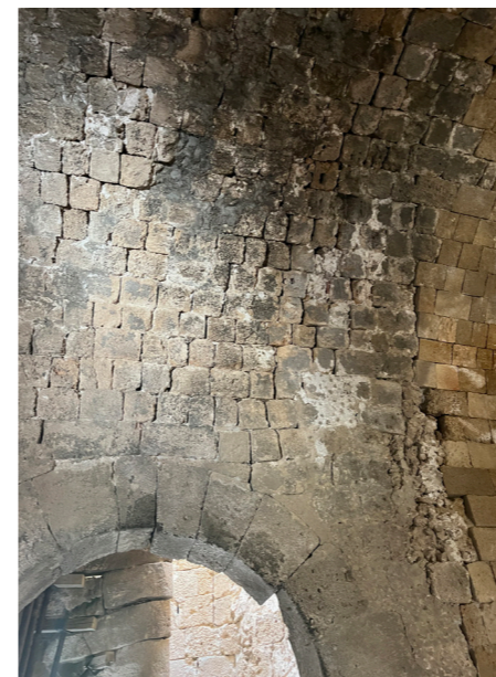
Εικ 13Α. Τμήμα θόλου βόρειας αίθουσας προς συντήρηση
